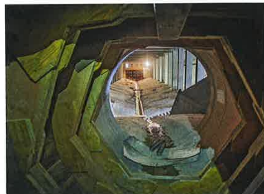
Blick vom Einlaufbauwerk ins Becken
