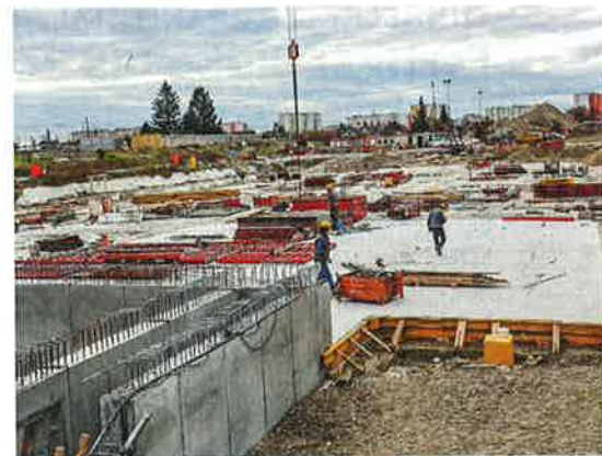
Das Baufeld liegt inmitten des Donautales
