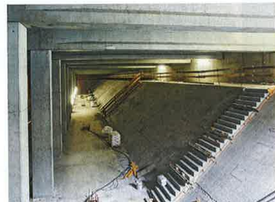
Das Becken erforderte ungewöhnliche Stabilisierungsmaßnahmen
