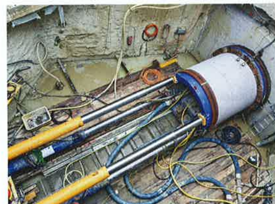
Der Vortrieb wird grabenlos im Micro-tunneling-Verfahren hergestellt
